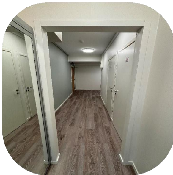
Korridor mot kök och toaletter
